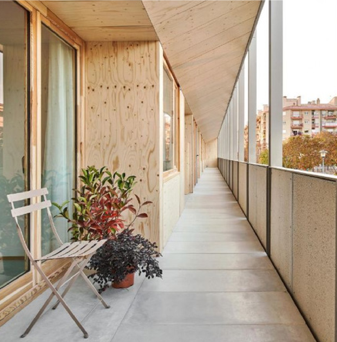
Diepe leefgalerij op eerste verdieping, beschutte plek
