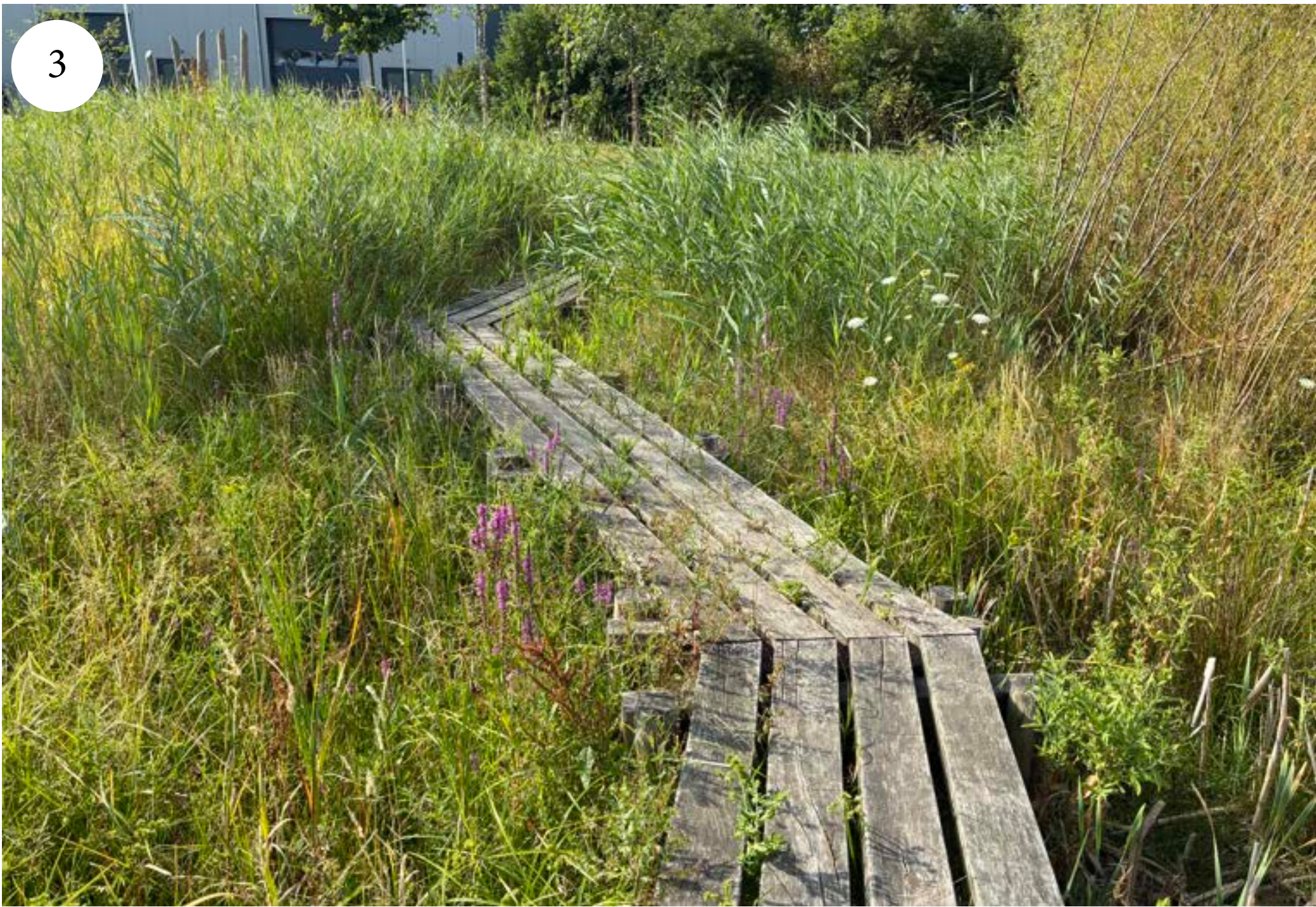
Coulissewerking met oeverbeplanting
