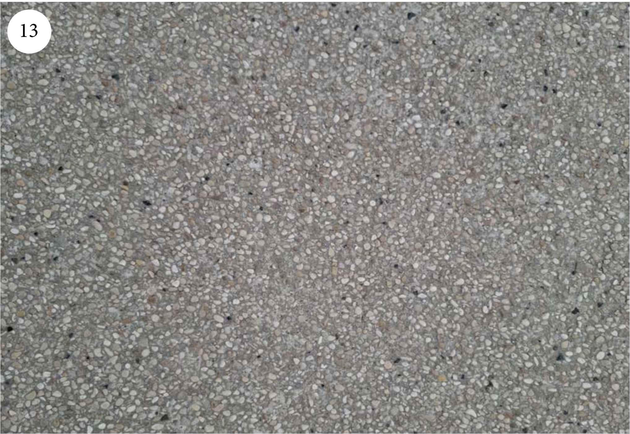
Asfalt pad met lichte toeslag
