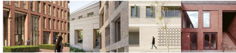
Herkenbare hoofdpoort over twee bouwlagen
