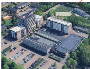
Locatie: Winkelcentrum Lindenburg 11 bouwlagen ca. 33 meter
