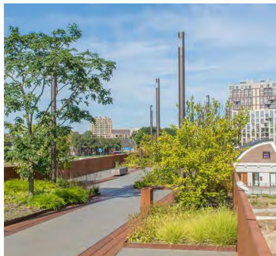
Kwalitatieve spoorwegovergang Paleisbrug, S'Hertogenbosch
