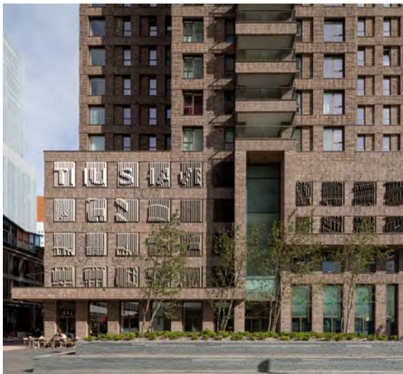
Parkeren tussen actieve plinten en woningen. Brick twins, Rotterdam
