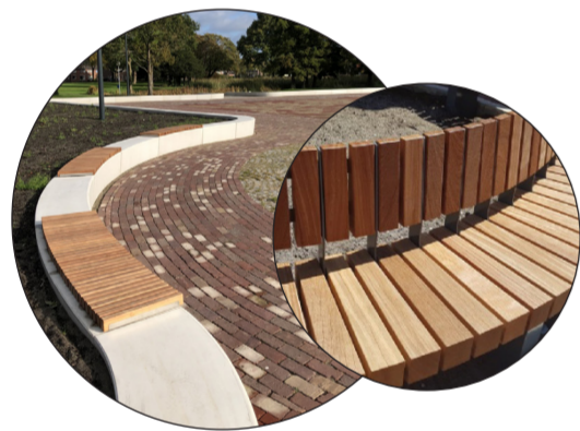
Zitbanken van beton met deels houten zittingen en rugleuning
