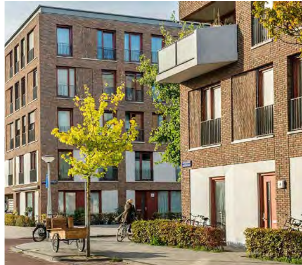
afb. 47 Afwijking in plint over twee lagen door kleurvlakken
