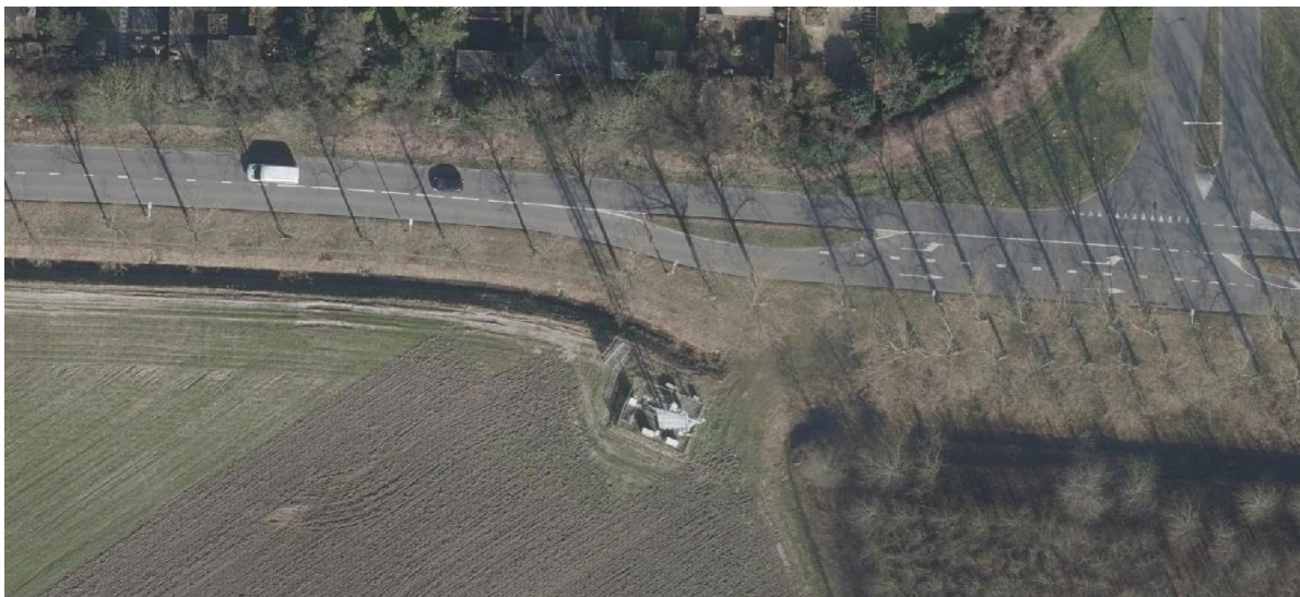
Luchtfoto zend-/ ontvangstinstallatie
