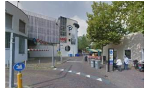
Zicht vanuit Nieuwstraat/Kuiperstraat (zuidoostzijde)
