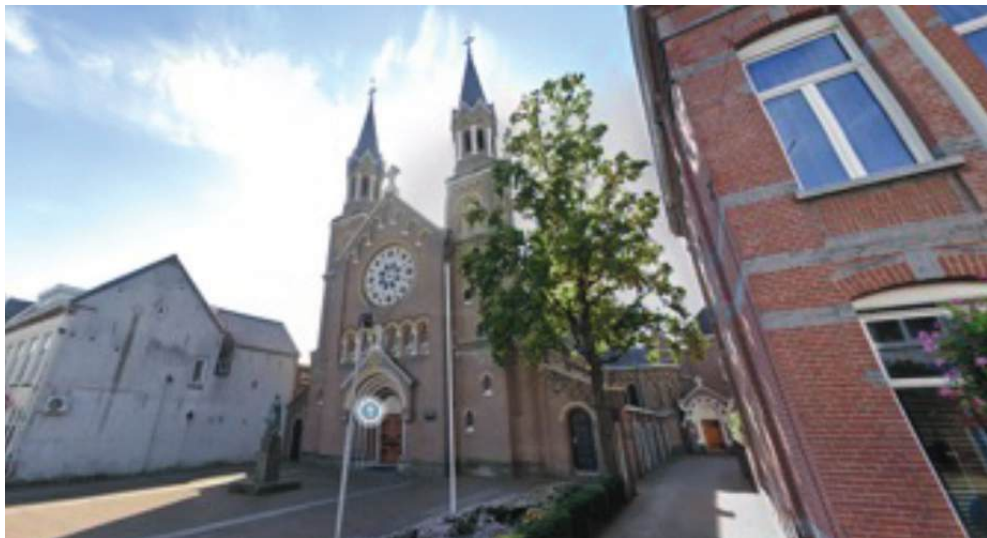
Zicht vanuit Kade (noordwest).
