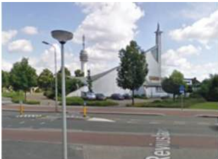
Zicht vanuit Revislaan (west).
