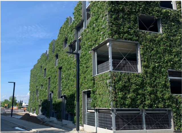
15. Gebouwde parkeervoorziening met groene gevels
