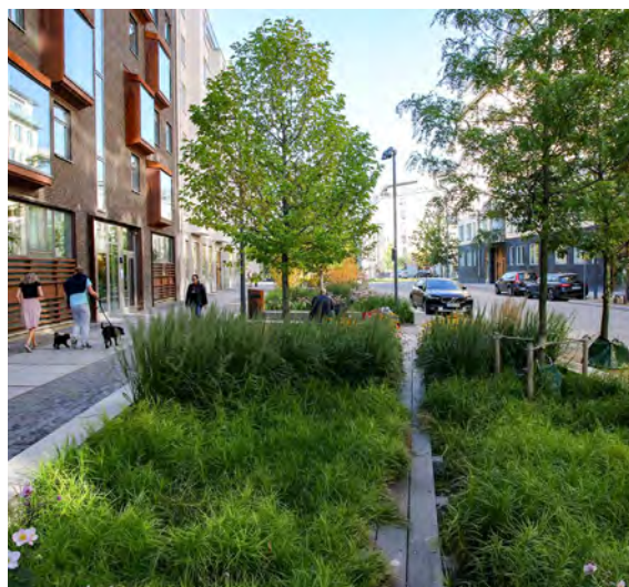
Regentuinen voor water buffering en waterverzameling Jaktgatan, Stockholm
