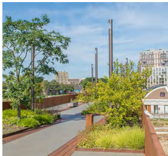
Kwalitatieve spoorwegovergang Paleisbrug, S'Hertogenbosch
